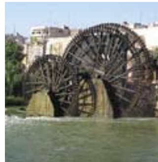
Рис. 227. Водяне колесо: а) схематичне зображення наливного колеса; б) сучасне використання підливного колеса для поливки; в) п'ятисотрічні підливні колеса на річці Оронт (Сірія)
