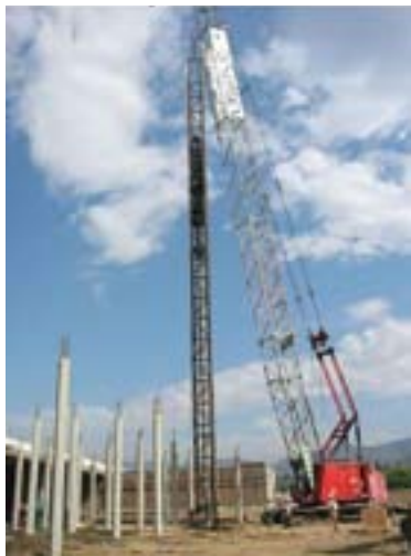
Рис. 222. Забивання паль під фундамент за допомогою будівельної машини — копера
